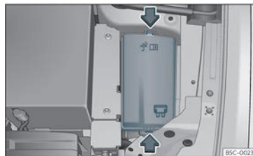
Fig. 48 I motorrummet: säkringsdosans lock.
